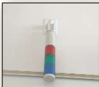
Εικόνα 203. Φωτοσήμανση σε τρία διαφορετικά χρώματα που ανάβουν για να ειδοποιήσουν και να υποδείξουν διαφορετικές καταστάσεις (π.χ. διάλειμμα, συναγερμός, κ.α.) (Rocky Mountain Deaf School, Denver, USA)
