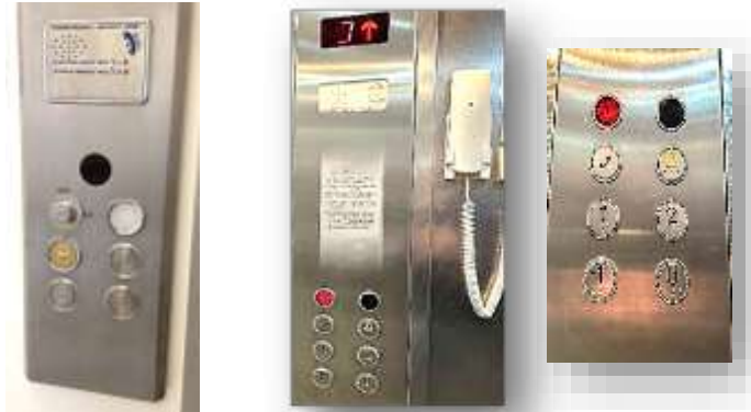
Εικόνες 85 & 86. Χειριστήρια με ανάγλυφες ενδείξεις (αριστερά: 5 ο Γυμνάσιο Πετρούπολης, δεξιά: Ε.Ε.Ε.ΕΚ. Ηρακλείου Αττικής)
