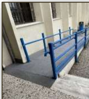
Εικόνα 8. Ράμπα παράλληλα στο κτίριο (1° Γυμνάσιο Γρεβενών)
