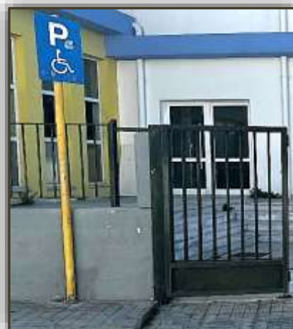
Εικόνα 195. Σήμανση πάρκινγκ για ΑμεΑ (Δημοτικό Σχολείο Κωφών και Βαρηκόων & Γυμνάσιο Ε.Α.Ε. Ηρακλείου, Κρήτης)
