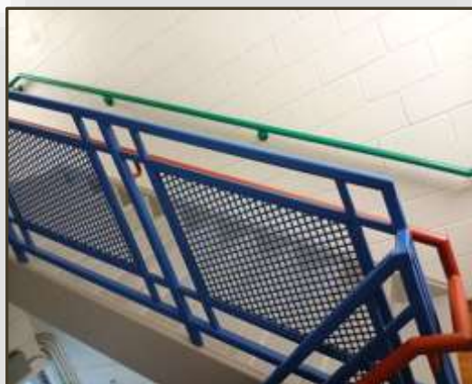
Εικόνες 73 & 74. Κλιμακοστάσιο - Χρωματική αντίθεση χειρολισθήρων (National Child Research Center Preschool, Washington, DC, USA)
