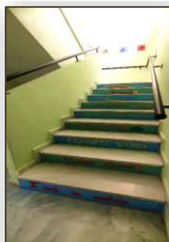
Εικόνα 76. Κλιμακοστάσιο (ΕΝ.Ε.Ε.ΓΥ.Λ. & Ε.Ε.Ε.ΕΚ. Αλεξανδρούπολης)
