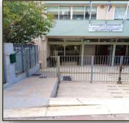
Εικόνα 7: Προσβάσιμη είσοδος σχολείου(σκάλα και ράμπα) (9° Δημοτικό σχολείο & 10° Δημοτικό σχολείο Ηρακλείου Αττικής)
