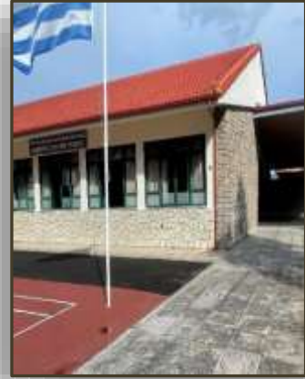
Εικόνα 44. Προαύλιος χώρος (Δημοτικό Σχολείο Γραβιάς)
