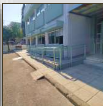
Εικόνα 9. Ράμπα παράλληλα στο κτίριο (4° Δημοτικό σχολείο Κω)
