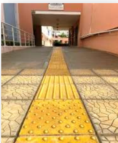
Εικόνα 22. Επιδαπέδια σήμανση (οδηγός τυφλών) (Ε.Ε.Ε.ΕΚ. Ηρακλείου Αττικής)
